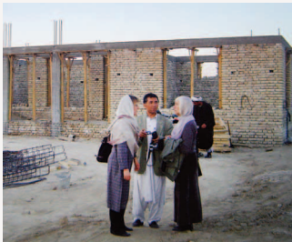
2005 Heike, Marga und Rahmanqul auf der Baustelle für das EC
